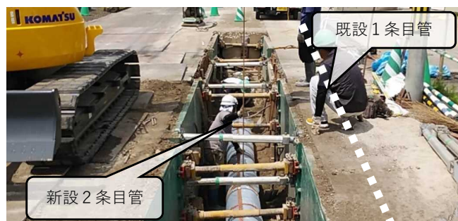
下水道管路の二条化による耐震化
