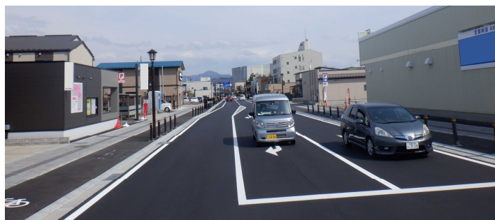
電柱の倒壊による道路の寸断を防止
