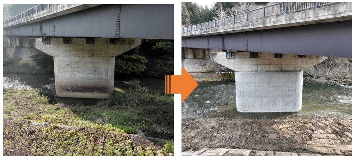
橋脚の巻立工法による耐震化
